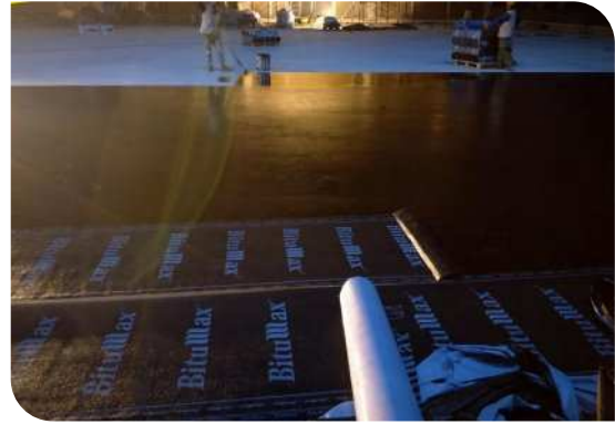
Thi công lăn lớp lót
