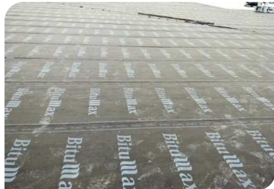
Bề mặt hoàn thiện
