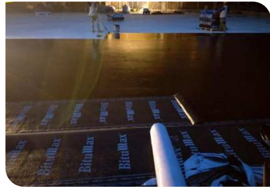
Thi công lăn lớp lót
