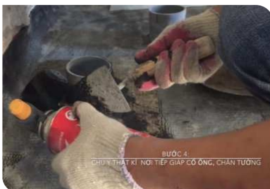
Xử lý cổ ống thoát nước
