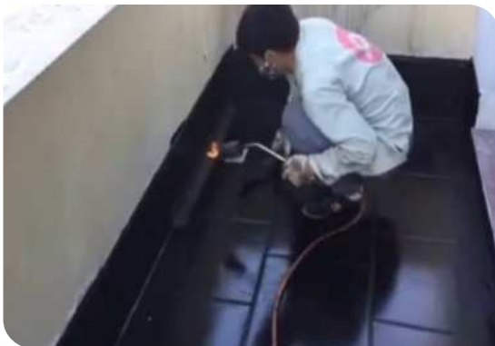
Xử lý góc chân tường
