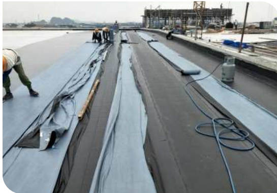
Thi công màng khô nóng
