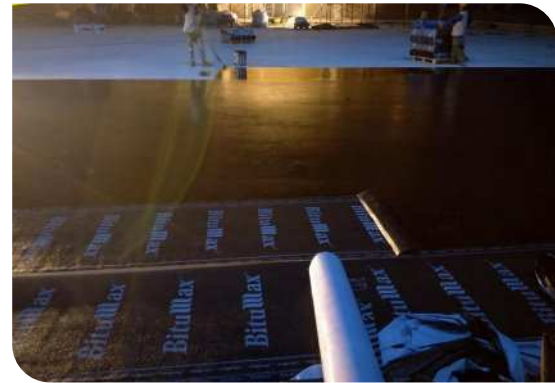
Thi công lăn lớp lót
