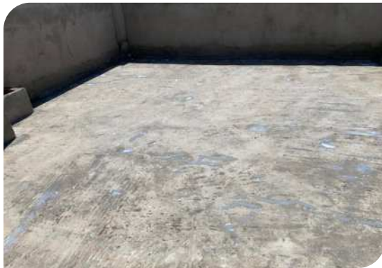
Chuẩn bị bề mặt
