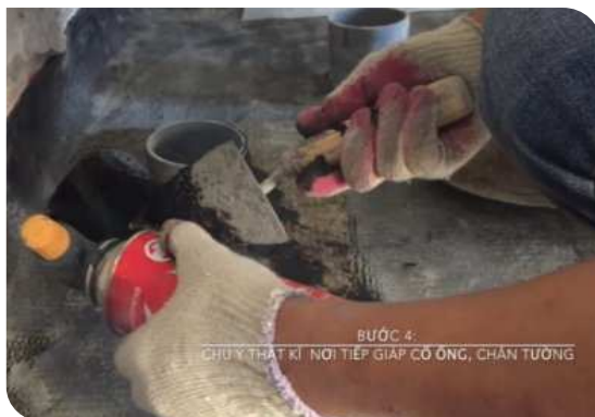
Xử lý cổ ống thoát nước
