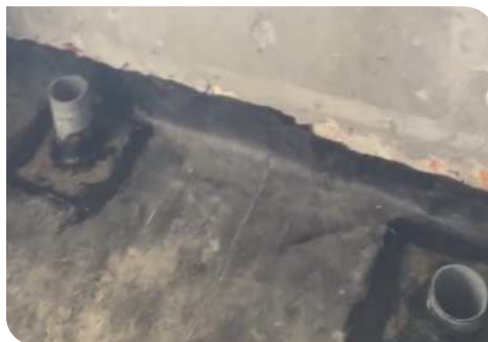
Hoàn thiện cổ ống và góc chân tường
