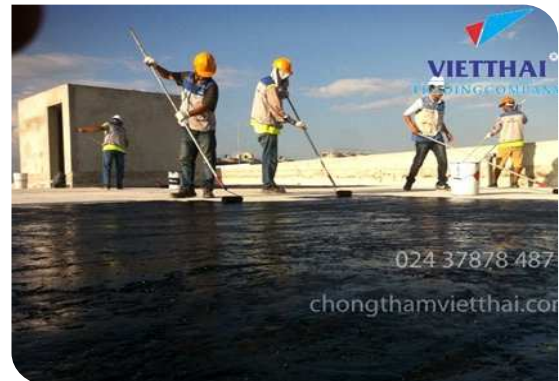
Thi công lăn lớp lót
