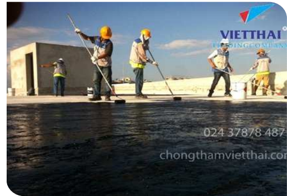
Thi công lăn lớp lót
