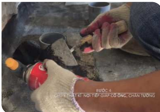
Xử lý cổ ống thoát nước
