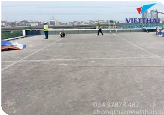
Chuẩn bị bề mặt
