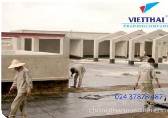
Thi công màng khô nóng
