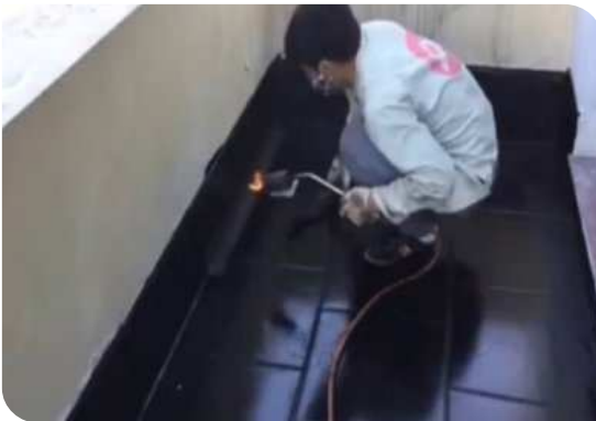
Xử lý góc chân tường
