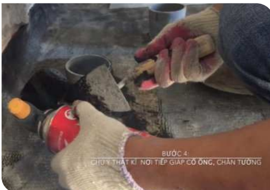
Xử lý cổ ống thoát nước
