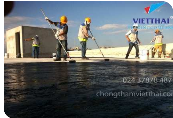
Thi công lăn lớp lót
