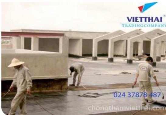
Thi công màng khô nóng
