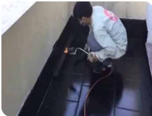
Xử lý góc chân tường
