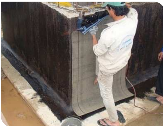
Thi công màng khô nóng
