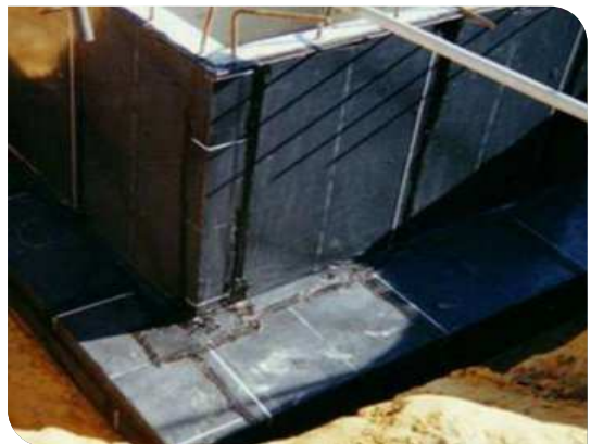
Bề mặt hoàn thiện
