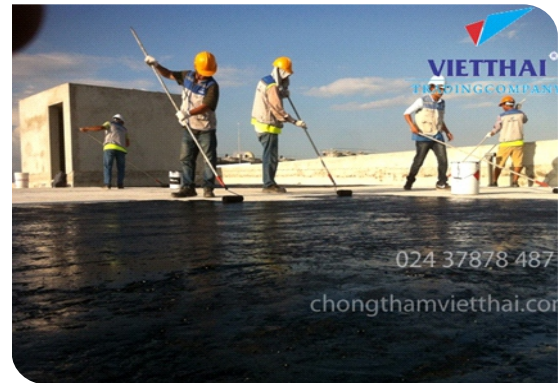
Thi công lăn lớp lót
