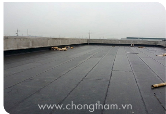
Bề mặt hoàn thiện
