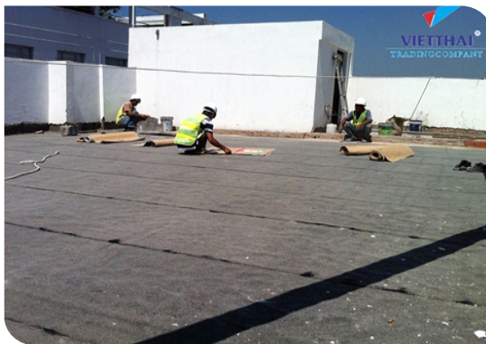
Thi công màng tự dính
