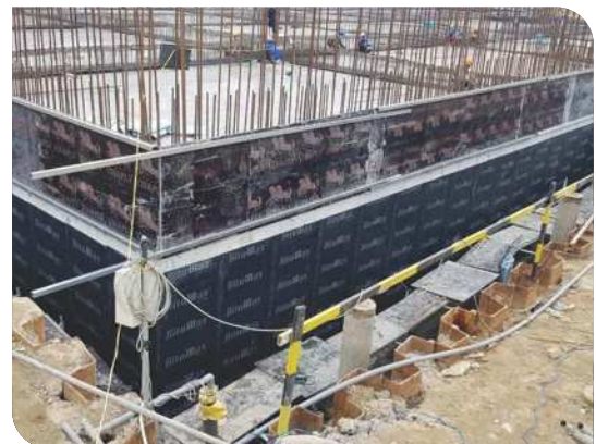
Bề mặt hoàn thiện
