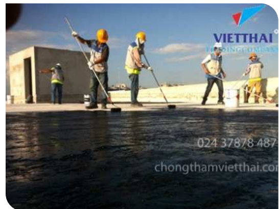
Thi công lăn lớp lót
