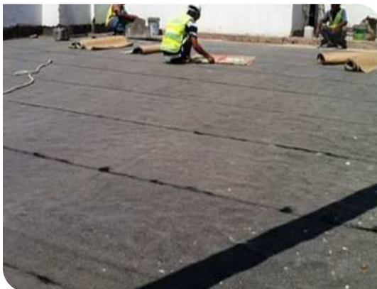
Thi công màng tự dính
