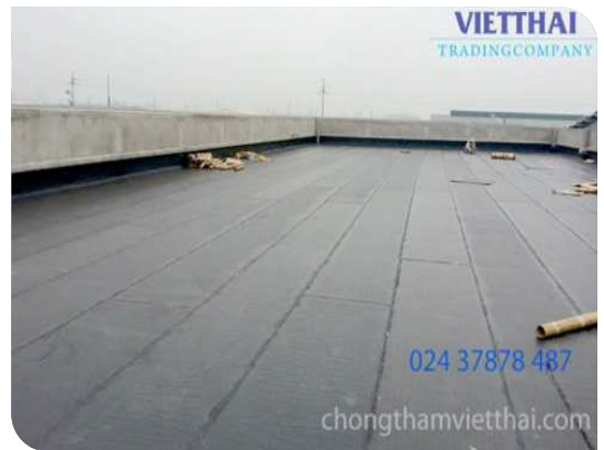
Bề mặt hoàn thiện
