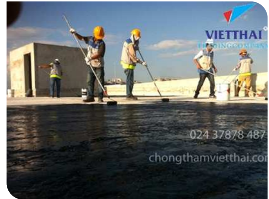
Thi công lăn lớp lót
