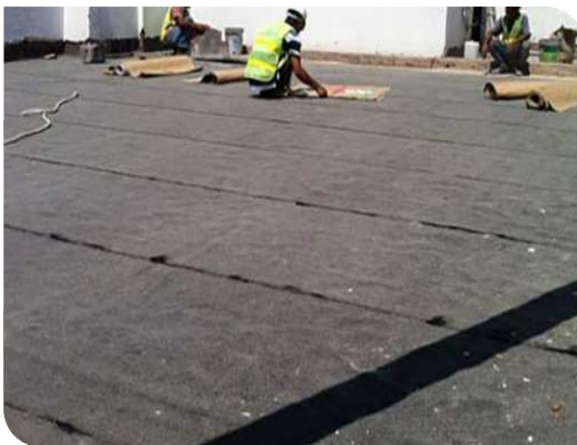
Thi công màng tự dính
