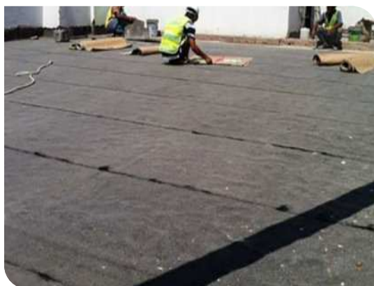
Thi công màng tự dính
