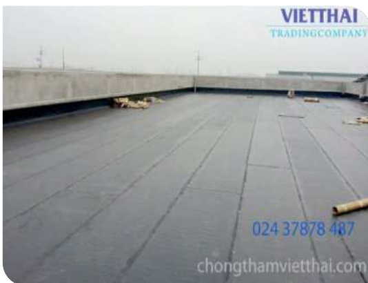
Bề mặt hoàn thiện
