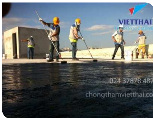
Thi công lăn lớp lót
