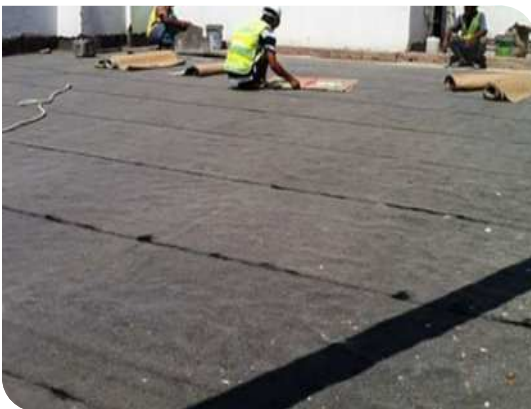
Thi công màng tự dính
