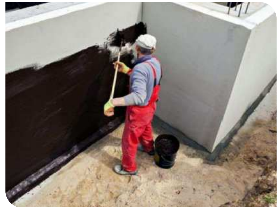
Thi công lăn lớp lót
