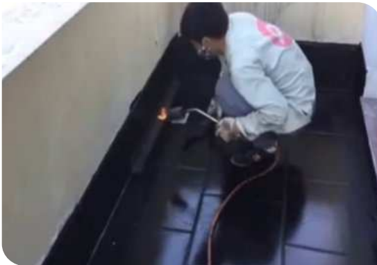
Xử lý góc chân tường
