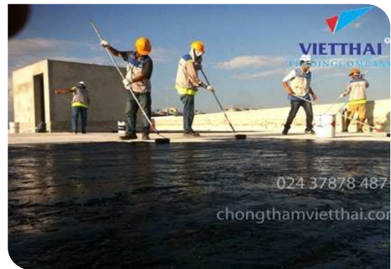
Thi công lăn lớp lót
