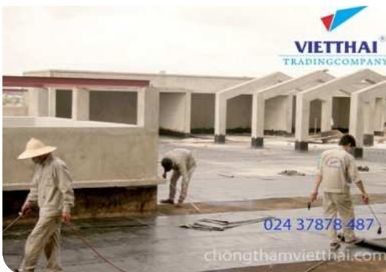
Thi công màng khò nóng
