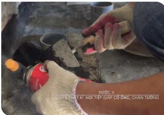
Xử lý cổ ống thoát nước
