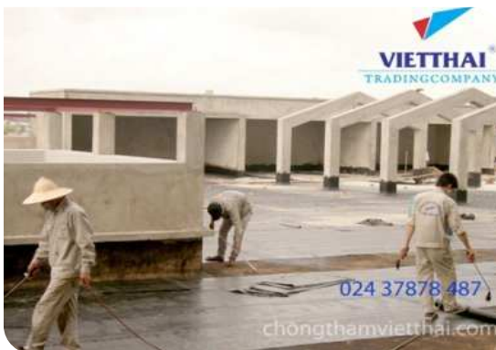
Thi công màng khô nóng
