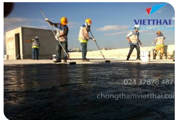
Thi công lăn lớp lót
