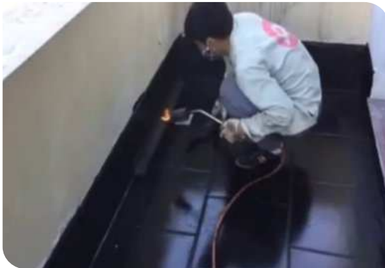
Xử lý góc chân tường
