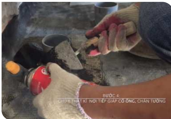
Xử lý cổ ống thoát nước
