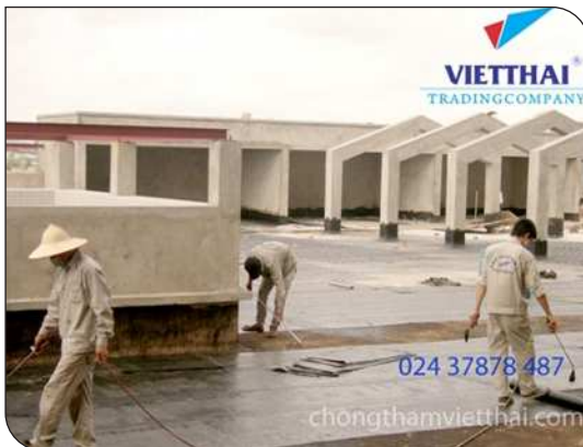
Thi công màng khô nóng
