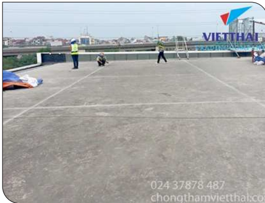
Chuẩn bị bề mặt
