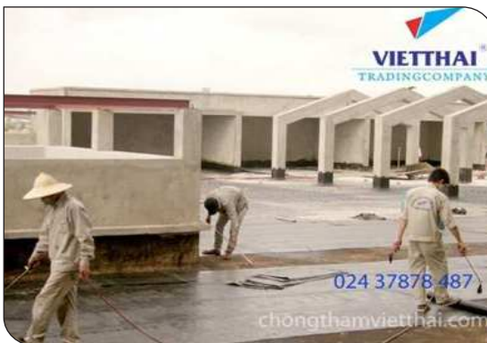
Thi công màng khò nóng
