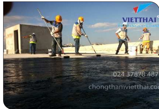
Thi công lăn lớp lót
