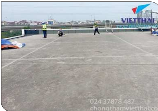
Chuẩn bị bề mặt
