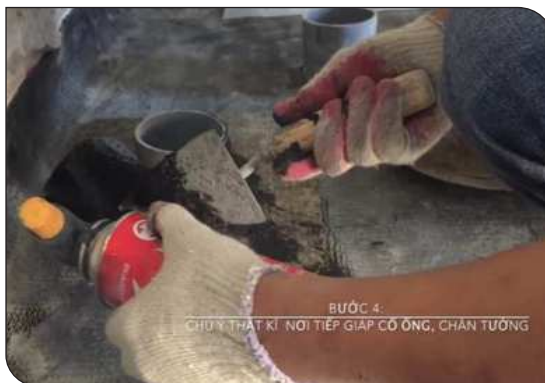
Xử lý cổ ống thoát nước
