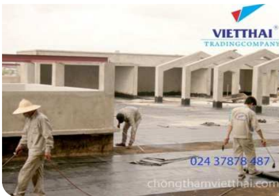
Thi công màng khô nóng
