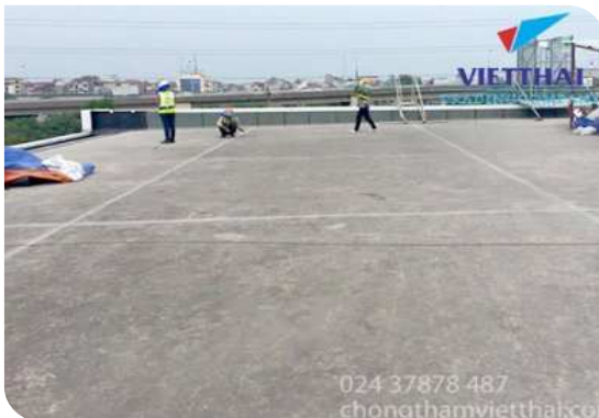
Chuẩn bị bề mặt
