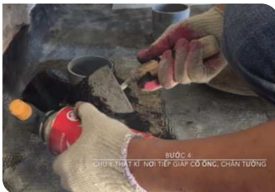
Xử lý cổ ống thoát nước
