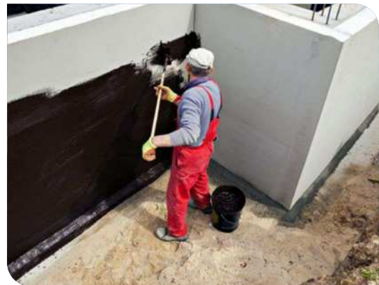
Thi công lăn lớp lót
