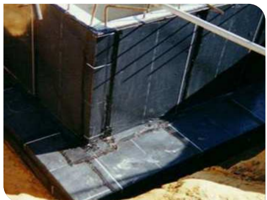
Bề mặt hoàn thiện
