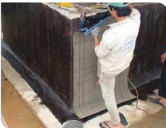
Thi công màng khô nóng
