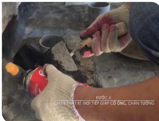
Xử lý cổ ống thoát nước
