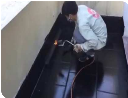
Xử lý góc chân tường
