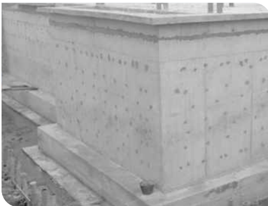
Chuẩn bị bề mặt
