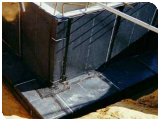
Bề mặt hoàn thiện
