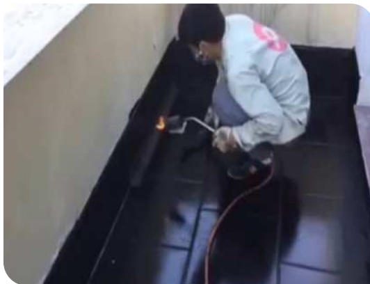
Xử lý góc chân tường
