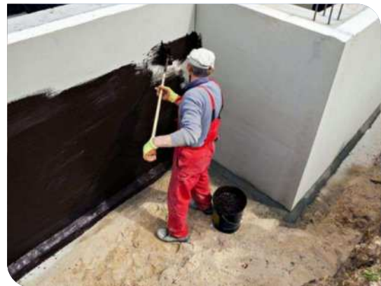
Thi công lăn lớp lót
