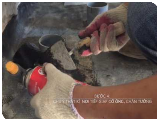
Xử lý cổ ống thoát nước
