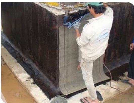
Thi công màng khô nóng
