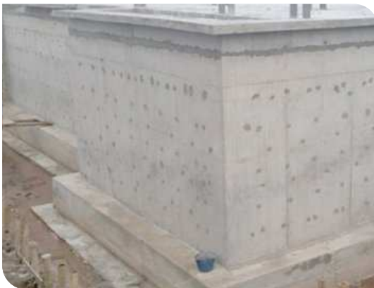
Chuẩn bị bề mặt
