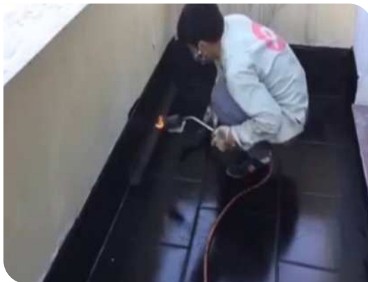
Xử lý góc chân tường
