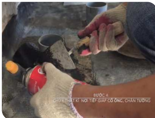
Xử lý cổ ống thoát nước
