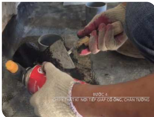
Xử lý cổ ống thoát nước
