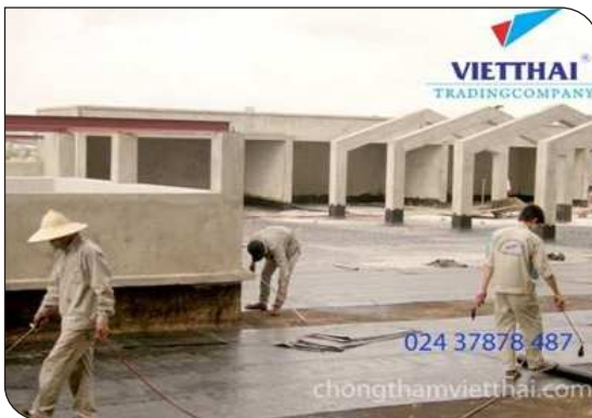
Thi công màng khô nóng
