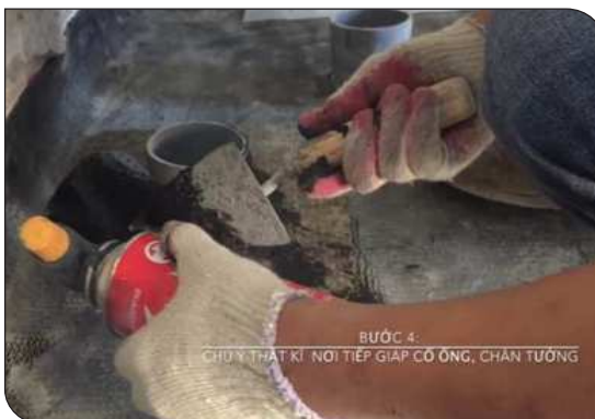
Xử lý cổ ống thoát nước
