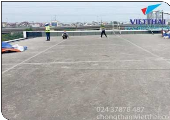
Chuẩn bị bề mặt
