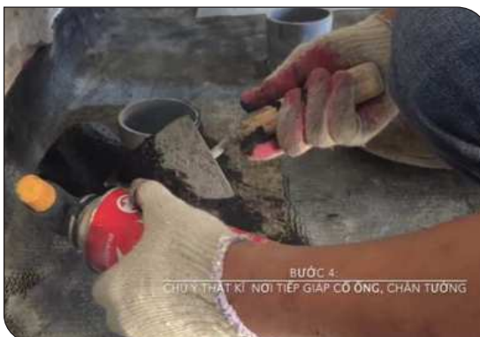
Xử lý cổ ống thoát nước
