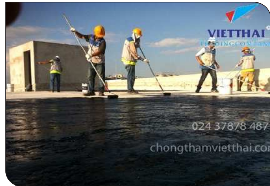
Thi công lăn lớp lót
