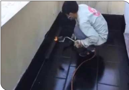
Xử lý góc chân tường
