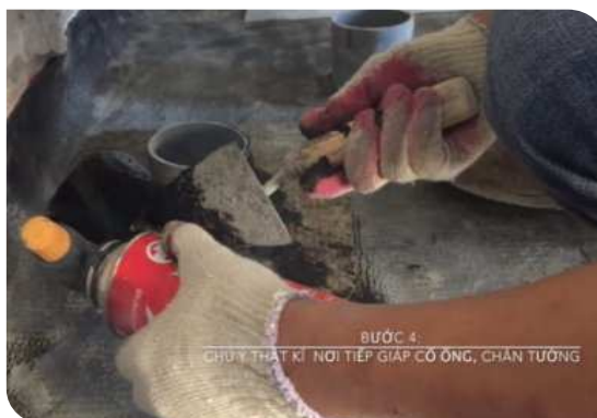
Xử lý cổ ống thoát nước
