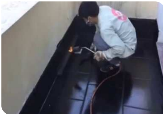
Xử lý góc chân tường
