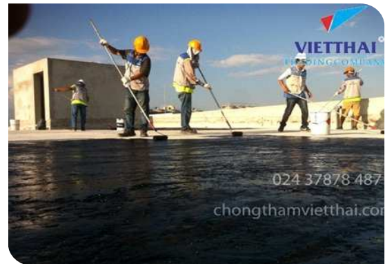
Thi công lăn lớp lót
