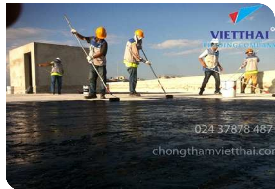
Thi công lăn lớp lót
