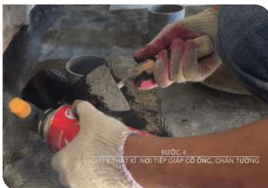
Xử lý cổ ống thoát nước
