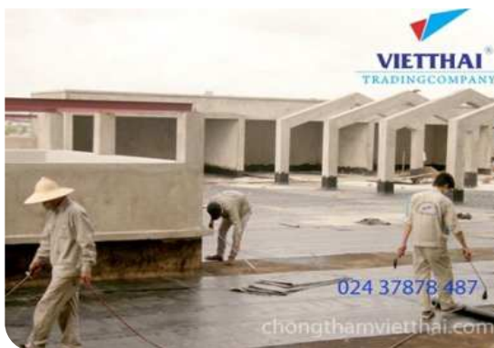
Thi công màng khô nóng
