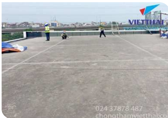
Chuẩn bị bề mặt
