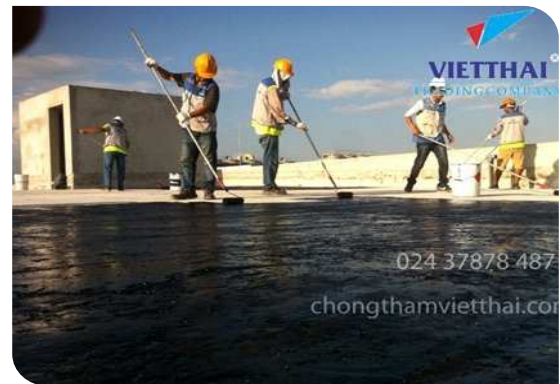
Thi công lăn lớp lót
