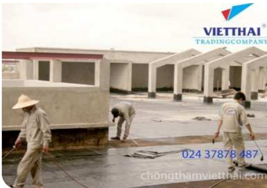
Thi công màng khô nóng
