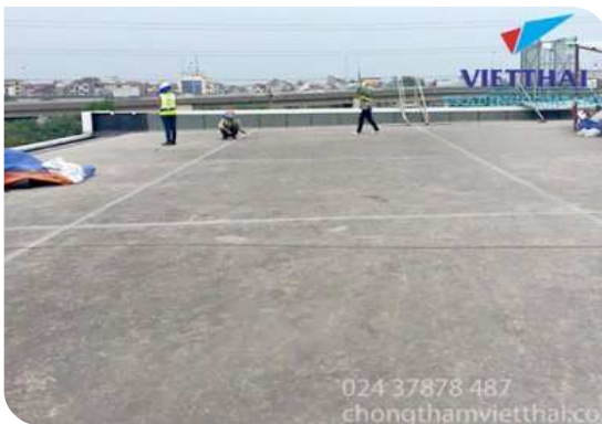
Chuẩn bị bề mặt
