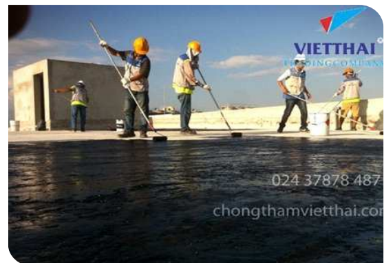
Thi công lăn lớp lót
