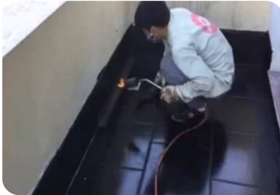
Xử lý góc chân tường
