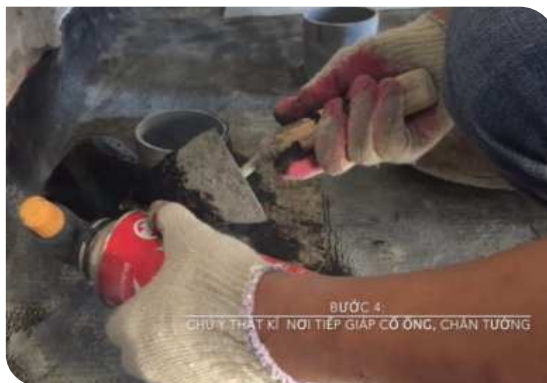
Xử lý cổ ống thoát nước
