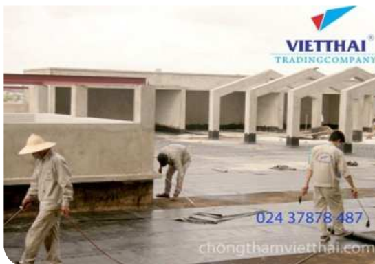
Thi công màng khô nóng
