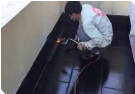
Xử lý góc chân tường
