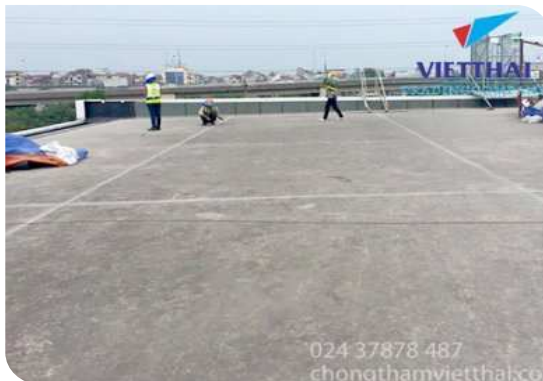
Chuẩn bị bề mặt
