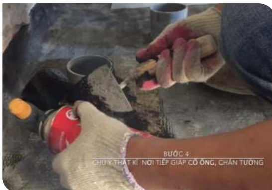
Xử lý cổ ống thoát nước
