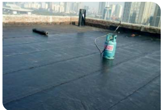
Bề mặt hoàn thiện
