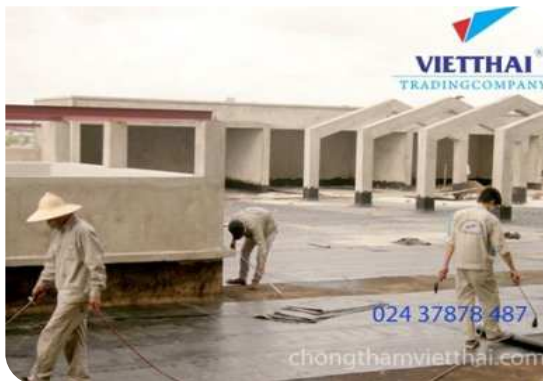
Thi công màng khò nóng
