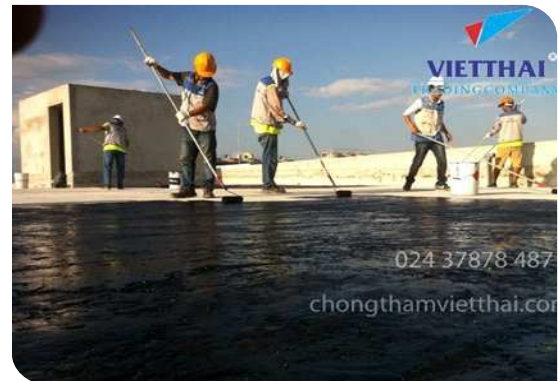
Thi công lăn lớp lót
