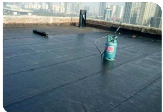
Bề mặt hoàn thiện
