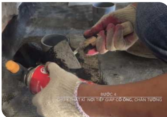
Xử lý cổ ống thoát nước
