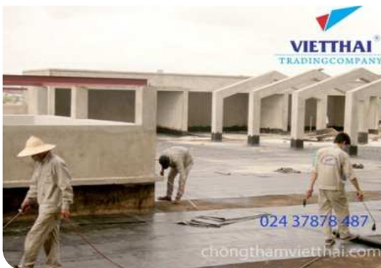
Thi công màng khô nóng
