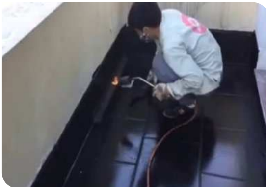
Xử lý góc chân tường
