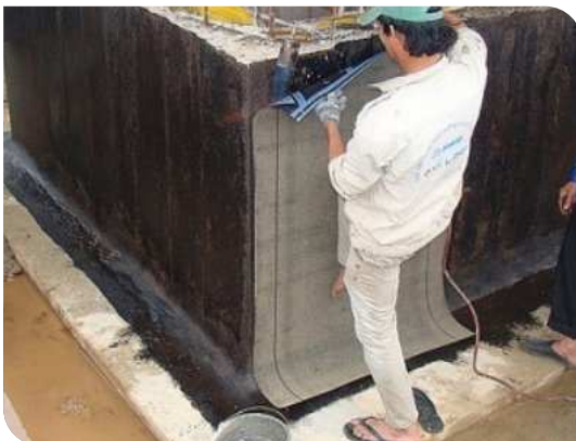
Thi công màng khô nóng
