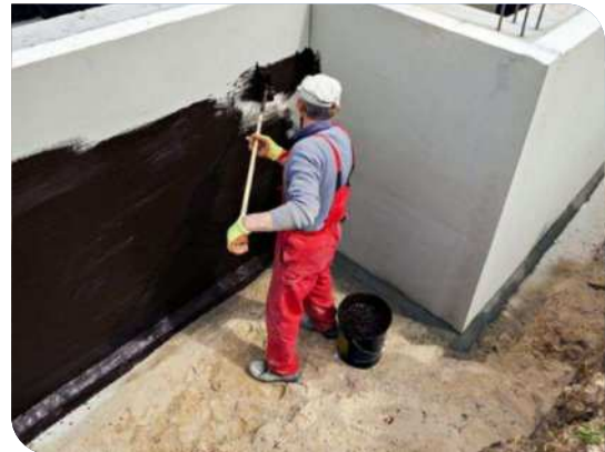
Thi công lăn lớp lót
