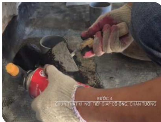
Xử lý cổ ống thoát nước
