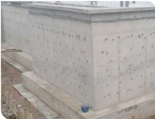
Chuẩn bị bề mặt
