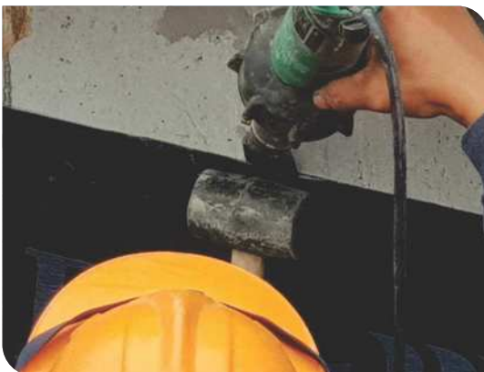
Thi công Hàn chồng mí bằng máy hàn điện
