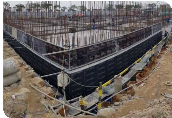
Bề mặt hoàn thiện
