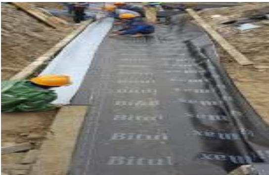
Thi công màng tự dính
