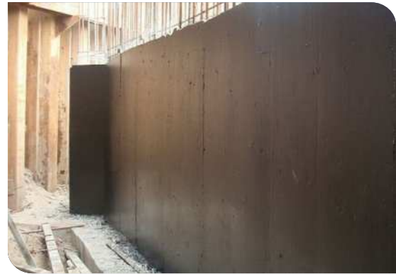
Thi công lăn lớp lót
