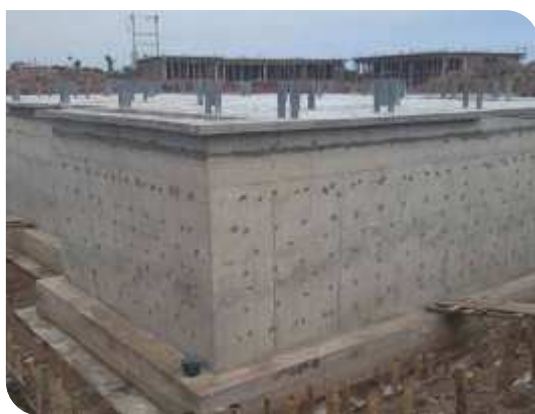
Chuẩn bị bề mặt
