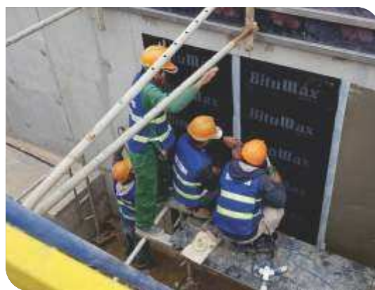
Thi công dán màng trên Hồ dầu xi măng
