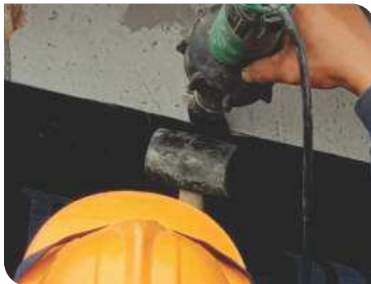
Thi công Hàn chong mí bằng máy hàn điện
