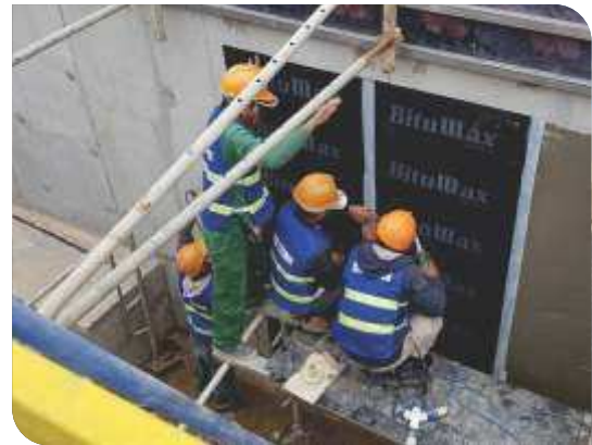
Thi công dán màng trên Hồ dầu xi măng
