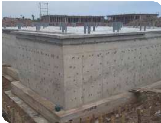
Chuẩn bị bề mặt
