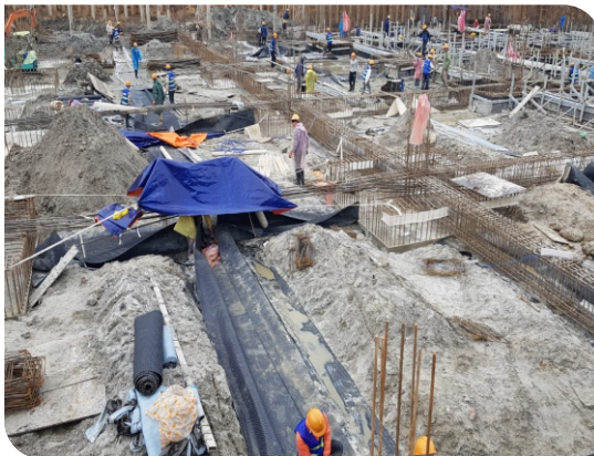
Thi công màng tự dính
