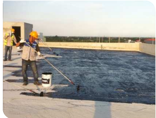
Thi công lăn lớp lót
