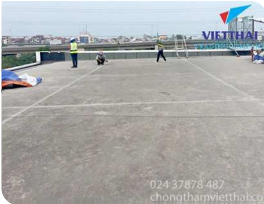
Chuẩn bị bề mặt
