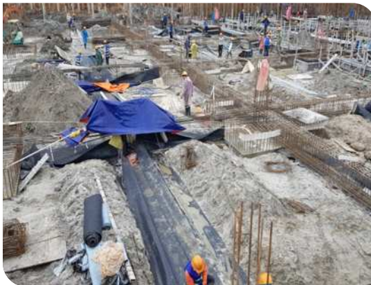
Thi công màng tự dính
