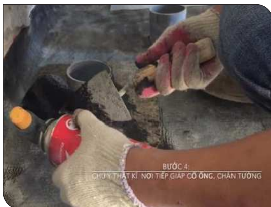
Xử lý cổ ống thoát nước
