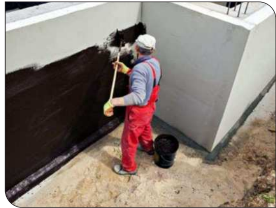
Thi công lăn lớp lót
