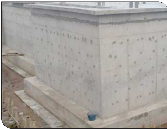
Chuẩn bị bề mặt
