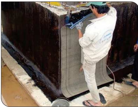
Thi công màng khô nóng
