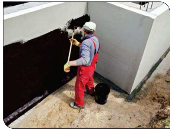
Thi công lăn lớp lót
