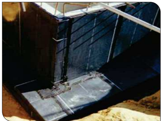
Bề mặt hoàn thiện
