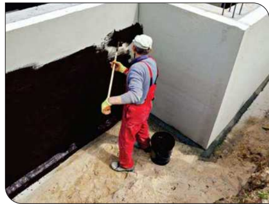
Thi công lăn lớp lót
