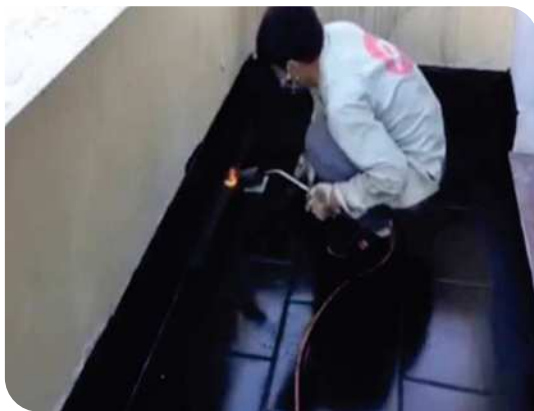
Xử lý góc chân tường
