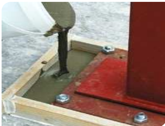
Thi công đổ vữa Grout
