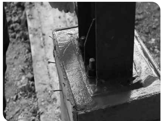
Chân cột sau khi đổ vữa Grout
