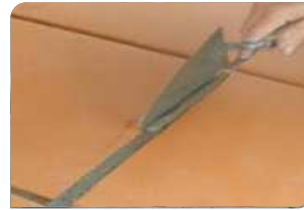
Trám và xử lý mạch gạch bằng keo trát mạch
