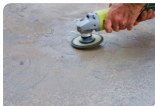
Sử dụng máy mài chà bề mặt bê tông
