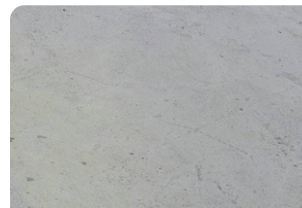
Bề mặt bê tông đạt
