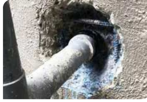
- Vệ sinh, quấn thanh trướng nở - Quét chất kết nối Revinox (pha với nước theo tỉ lệ 1:4)
