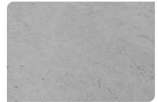
Bề mặt bê tông đạt
