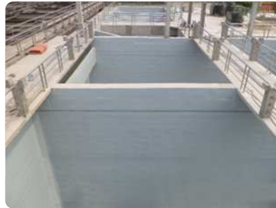
- Vệ sinh, quấn thanh trướng nở - Quét chất kết nối Revinox (pha với nước theo tỉ lệ 1:4)
