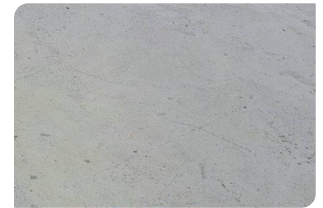
Bề mặt bê tông đạt
