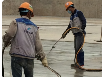
- Vệ sinh, quấn thanh trướng nở - Quét chất kết nối Revinex (pha với nước theo tỉ lệ 1:4)
