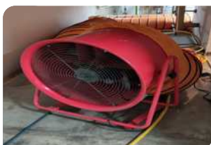
Lắp đặt chuẩn bị quạt hút thông gió
