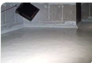
Lắp đặt chuẩn bị đèn chiếu sáng
