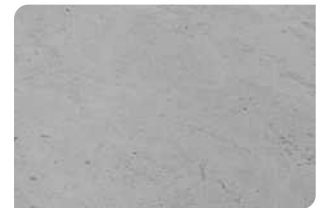
Bề mặt bê tông đạt
