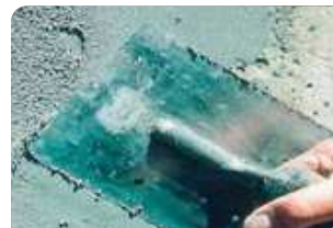
Trám vá bề mặt bê tông bằng vữa sửa chữa Neorep
