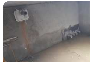
Thi công ghép cốt pha và đổ vữa Lemax Grout LM-G650
