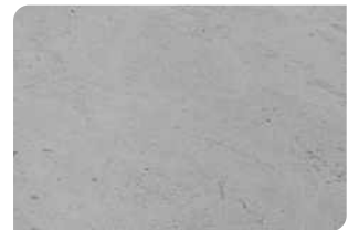
Bề mặt bê tông đạt
