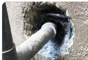
- Vệ sinh, quăn thanh trường nở - Quét chất kết nối Revinex (pha với nước theo tỉ lệ 1:4)
