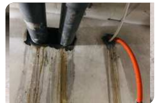
Trám vá hoàn thiện bề mặt bằng vữa sửa chữa Neorep
